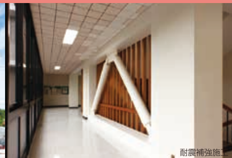
耐震補強施工
