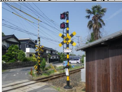
全方向踏切警報灯
