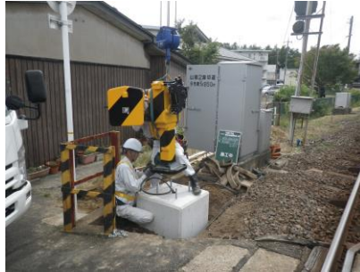
踏切遮断機取替工事
