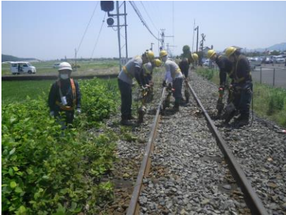
道床つき固め工事
