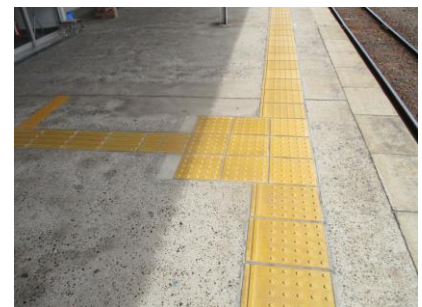
(内方線付点状ブロックの設置)
