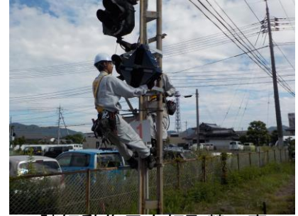
踏切動作反応灯取替工事
