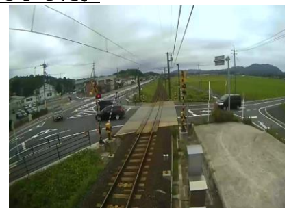
踏切監視システム
